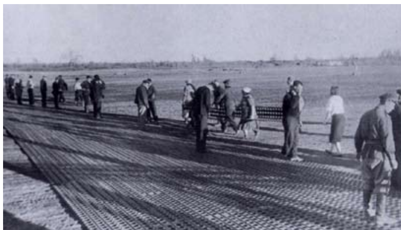
Укладка взлётно-посадочной полосы на аэродроме г. Якутска
